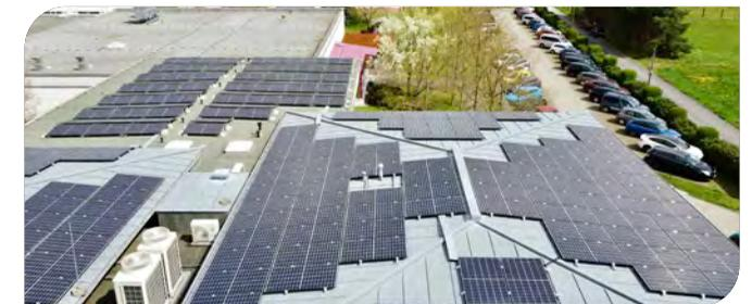
Die Fähigkeit, unabhängig zu agieren, ist ein weiterer großer Vorteil unserer Anlage. Bei einem Netzausfall können wir uns auf unsere Photovoltaikanlage und den Batteriespeicher verlassen, um die kritischen Betriebsabläufe unterbrechungsfrei aufrechtzuerhalten. Mit einer autarken Versorgung von bis zu drei Tagen sind wir für unvorhergesehene Situationen bestens gerüstet.
